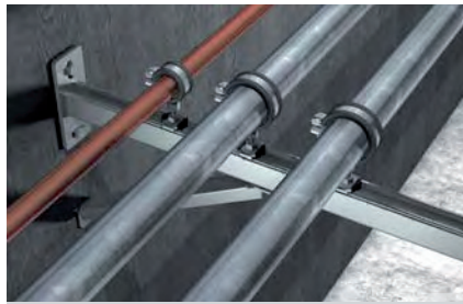
Rohrbefestigung entlang der Wand
